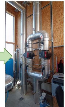
Netzpumpen → Wärmenetz
